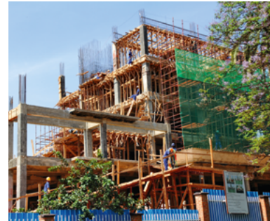
Links: Straßenbau in Kinigi Rechts: Bau eines Bürogebäudes im Zentrum Kigalis
