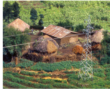
Links: Bau eines Ausleitungskanals für die Energieerzeugung einer Kleinstadt nahe der Bulera Falls im Nordwesten Ruandas Rechts: Neue Stromleitung vor traditionellem Dorf bei Mudende
