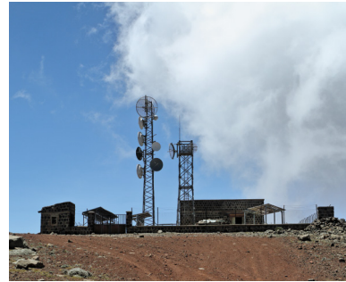
Links: Mitarbeiterin einer Textilfabrik bei der Kontrolle des Produktionsprozesses. Rechts: Mobilfunkstation in den Bergen von Bale
