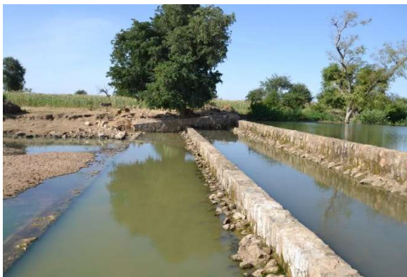
Flussschwelle, © GIZ- Team GERTS
