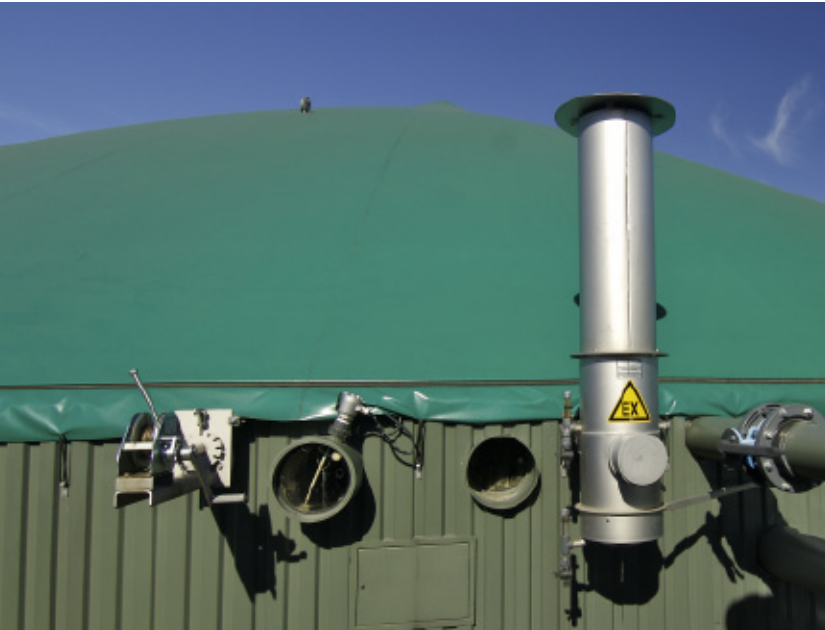
Dispositivo de protección contra sobrepresión y subpresión en un digestor
