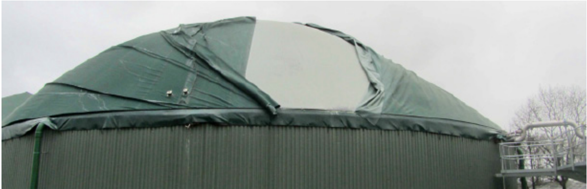
Ejemplo de rasgado de la membrana en un almacenamiento de gas
