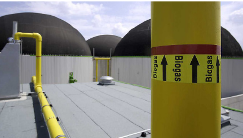
Tuberías de gas (y etiquetado)
