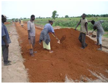
Travaux d'aménagement d'un chemin d'accès au marché de Gounou Gaya
