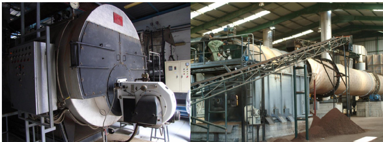
Figure 32: Chaudières typiques de production de vapeur industrielle ou de séchage 214
