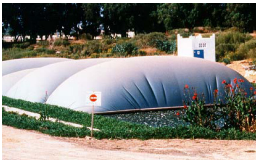
Figure 23: Récupération de biogaz dans un lagunage (Bensergao, Agadir) 190
