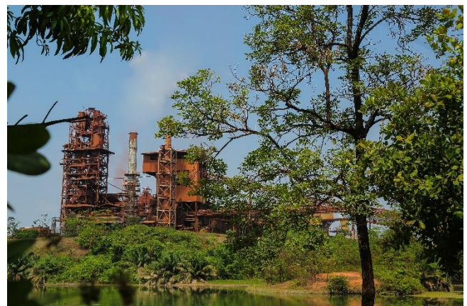
Ferronickel-Bergwerk, Cerro Matoso, Kolumbien
