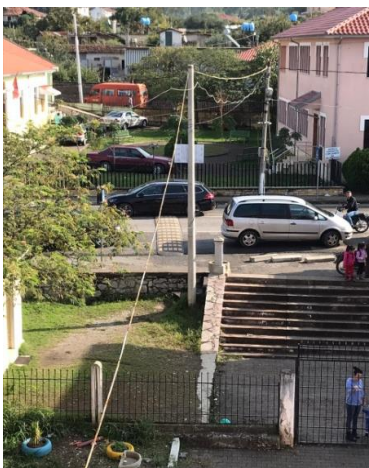
Kabllot elektrike që kalojnë në oborr dhe shtylla elektrike
