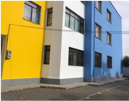
Kabllo elektrike që kalojnë në oborr
