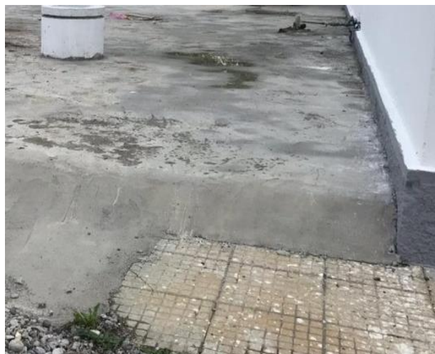
Shtresa e betonit e shtruar për lagështirën
