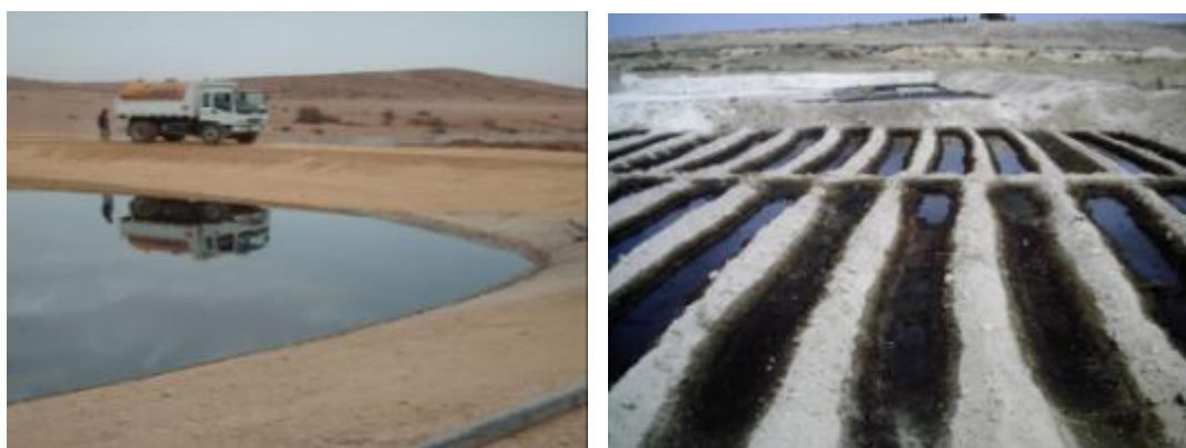
Figure 25:Traitement de lixiviat dans le CET d'Oujda 107
