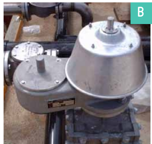
FIGURA 8.6 A) CORTE ESQUEMÁTICO DE UN ARREGLO DE VÁLVULA DE ALIVIO DE PRESIÓN/ROMPEDORA DE VACÍO Y (B) ARREGLO DE VÁLVULA DE ALIVIO DE PRESIÓN/ROMPEDORA DE VACÍO ACOPLADO A ARRESTAFLAMA VERTICAL.
