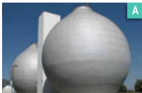
FIGURA 3.24 FOTOS DE DIGESTORES DE LODO: A) FORMA OVOIDE EN LA PTAR WASSMANSDORF - ALEMANIA; B) PTAR NECKARSULM - ALEMANIA; C) SAPAL (PTAR LEÓN, MÉXICO); D) CIAPACOV (PTAR PASO LIMÓN, COLIMA, MÉXICO).
