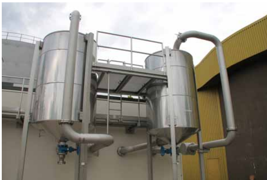
FIGURA 6.4 DESULFURIZACIÓN CON FILTROS DE CARBÓN ACTIVADO.
