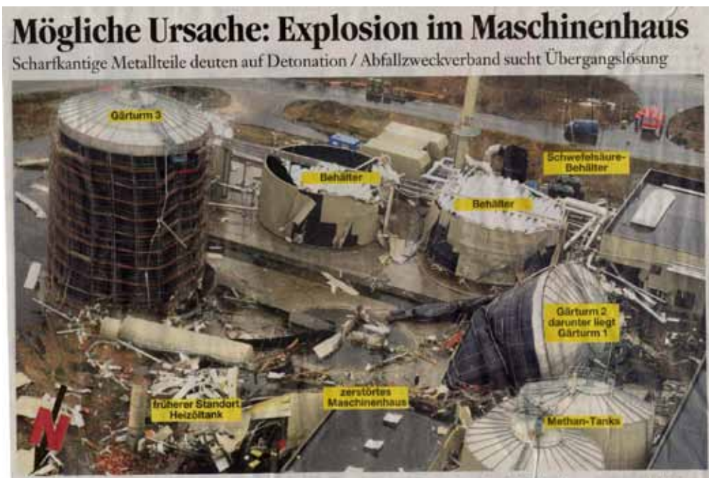
FIGURA 9.2 PLANTA DE BIOGÁS EN ALEMANIA DESPUÉS DE UNA EXPLOSIÓN.
