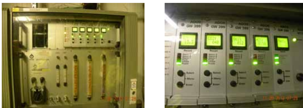
FIGURA 8.16 ESTACIÓN DE MEDICIÓN MULTIPARAMÉTRICA DEL MEDIO AMBIENTE.
