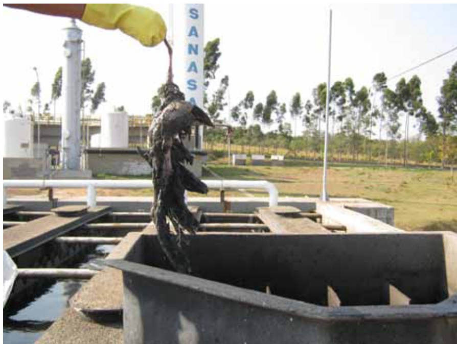
FIGURA 3.6 REMOCIÓN DE RESIDUOS EN LA CAJA DE DISTRIBUCIÓN DE EFLUENTE DE LOS REACTORES UASB.
