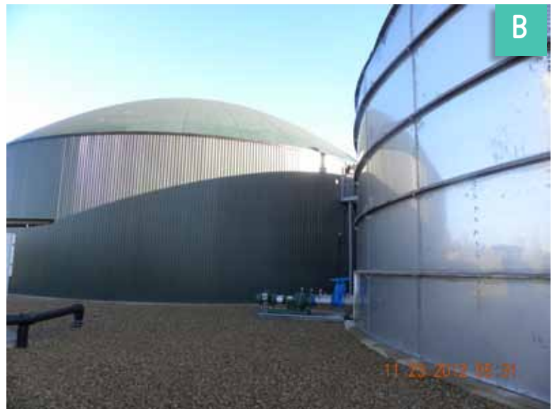
FIGURA 4.22 GASÓMETRO INTEGRADO A DIGESTOR. A) DIGESTOR DE LA PTAR EN ACAPATZINGO, MORELOS, MÉXICO Y B) DIGESTOR EN LA PTAR KETTERING, INGLATERRA.
