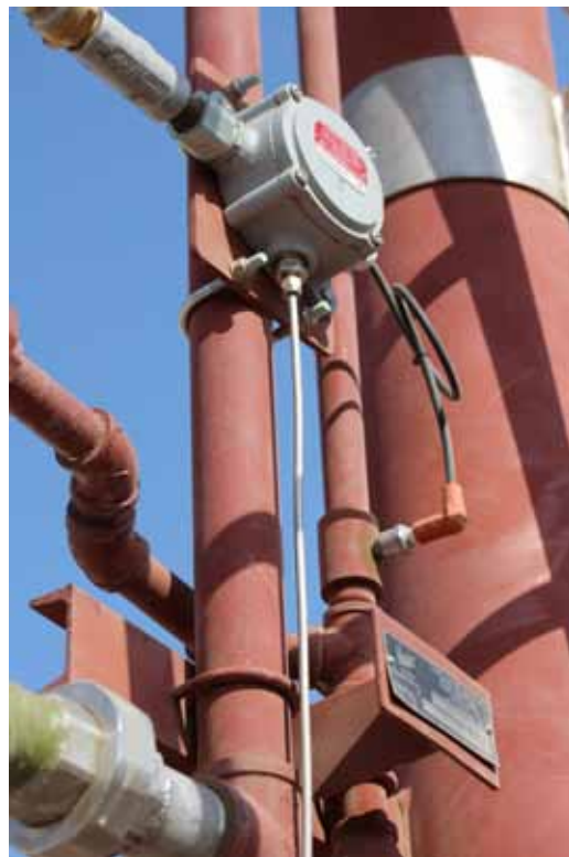
FIGURA 5.5 SISTEMA DE IGNICIÓN BASADO EN TRANSFORMADOR Y BUJÍA.
