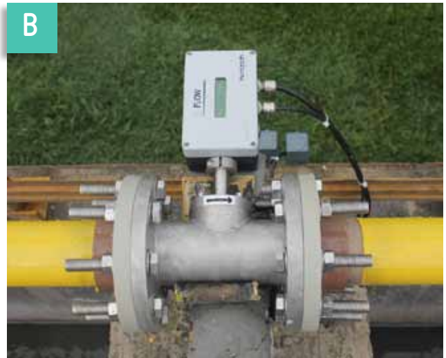
FIGURA 8.14 MEDIDORES DE SALIDA DE BIOGÁS: A) Y B) TIPO VÓRTEX; C) Y D) TIPO MÁSSICO POR DISPERSIÓN TÉRMICA, E) Y F) ULTRASÓNICO.
