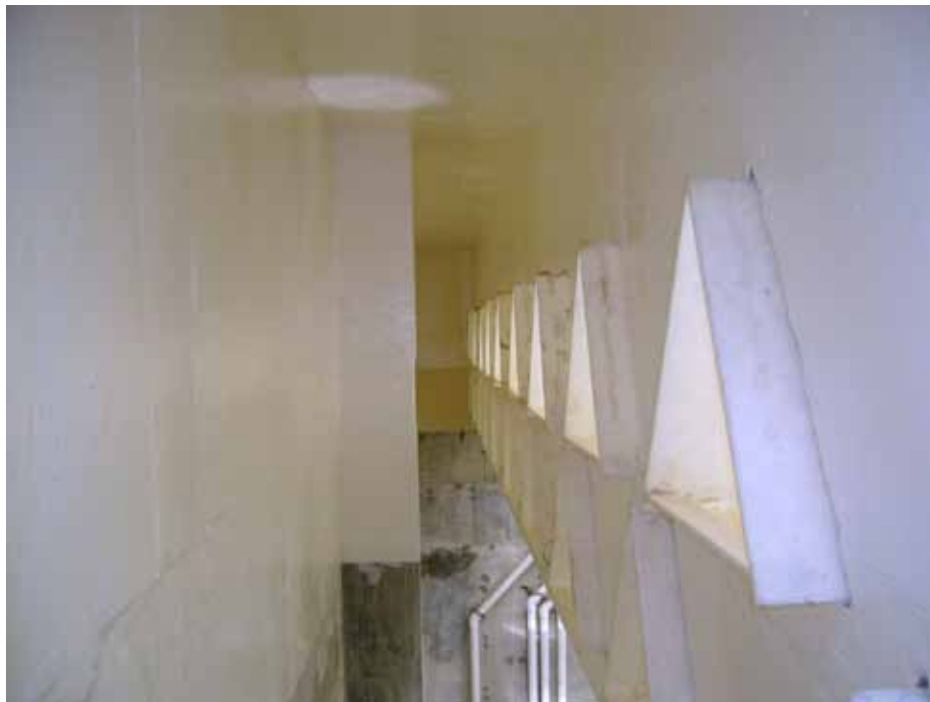
FIGURA 3.16 SISTEMA DE SEPARACIÓN TRIFÁSICO CON DESCARGA LATERAL DE BIOGÁS HACIA UNA CÁMARA DE RECOLECCIÓN DE ÉSTE.
