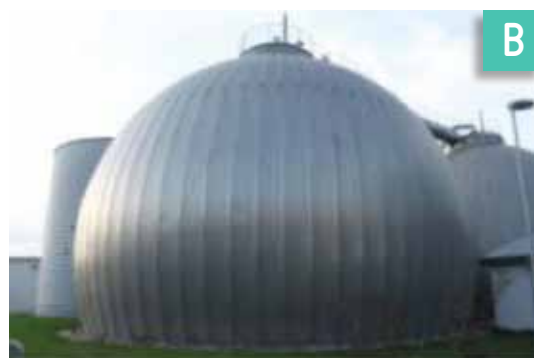
FIGURA 3.24 FOTOS DE DIGESTORES DE LODO: A) FORMA OVOIDE EN LA PTAR WASSMANSDORF - ALEMANIA; B) PTAR NECKARSULM - ALEMANIA; C) SAPAL (PTAR LEÓN, MÉXICO); D) CIAPACOV (PTAR PASO LIMÓN, COLIMA, MÉXICO).
