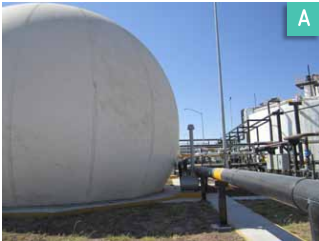
FIGURA 4.9 GASÓMETRO A) DE DOBLE MEMBRANA DE LA PTAR DE SAN PEDRO MÁRTIR, QUERÉTARO; B) DE TUBOS INFLABLES DE LA PTAR INDUSTRIAL CARL MACHER, ALEMANIA; C) Y D) CON MEMBRANA Y LASTRE DE LA PTAR TAUNUSSTEIN, ALEMANIA; E) Y F) DE MEMBRANA EN PTAR DE CASA CUERVO, MÉXICO Y LASTRE CON CILINDRO TELESCÓPICO EN PTAR CCM TECATE, MÉXICO.
