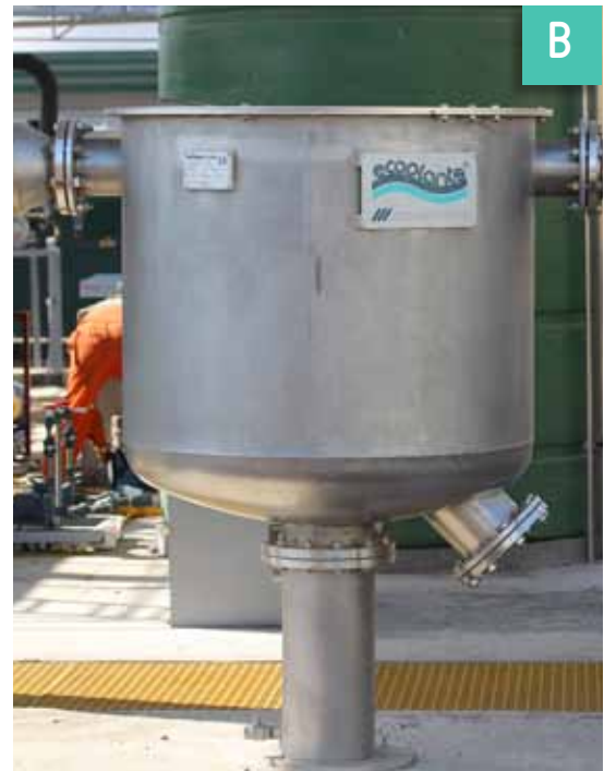
FIGURA 8.3 A) DIAGRAMA ESQUEMÁTICO DE UN FILTRO DE GRAVA O DE CERÁMICA PARA REMOCIÓN SIMULTÁNEA DE SEDIMENTOS Y DE CONDENSADOS Y B) FOTO DE FILTRO DE GRAVA
