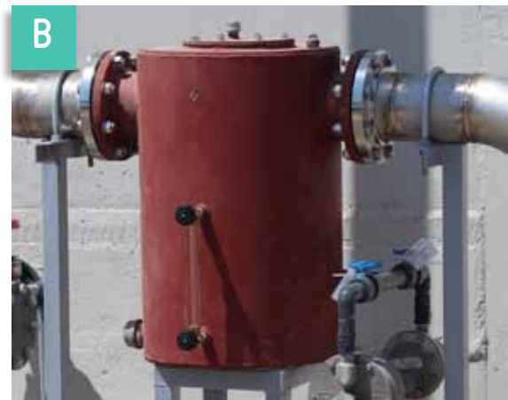
FIGURA 8.5 TRAMPAS A) DE SEDIMENTOS DE 10 GALONES EN ACERO INOXIDABLE (PARA SITIOS DONDE EL GAS ES MUY HÚMEDO) Y B) DE SEDIMENTOS DE 6 GALONES EN ACERO AL CARBÓN RECUBIERTO INTERIORMENTE (PARA SITIOS CON BAJA HUMEDAD).
