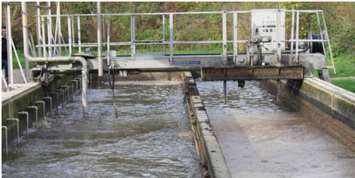
FIGURA 3.7 DESARENADOR AIREADO CON RETIRO SIMULTÁNEO DE GRASA.
