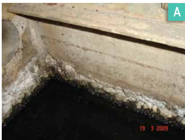
FIGURA 3.19 A) PARED INTERNA DEL REACTOR UASB CON SEÑAL DE CORROSIÓN EN LA INTERFASE LÍQUIDO-AIRE. B) PARTE SUPERIOR DE LA CANALETA DE CEMENTO DEL EFLUENTE TRATADO DEL REACTOR UASB COMPROMETIDA POR LA CORROSIÓN.
