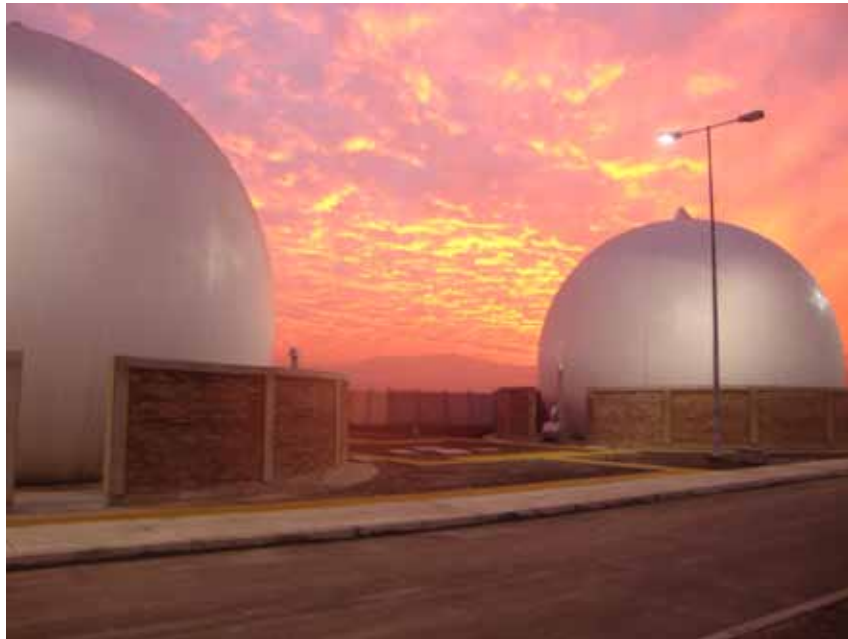
FIGURA 9.6 PROTECCIÓN CONSTRUCTIVA PARA GASÓMETROS DE DOBLE MEMBRANA.
