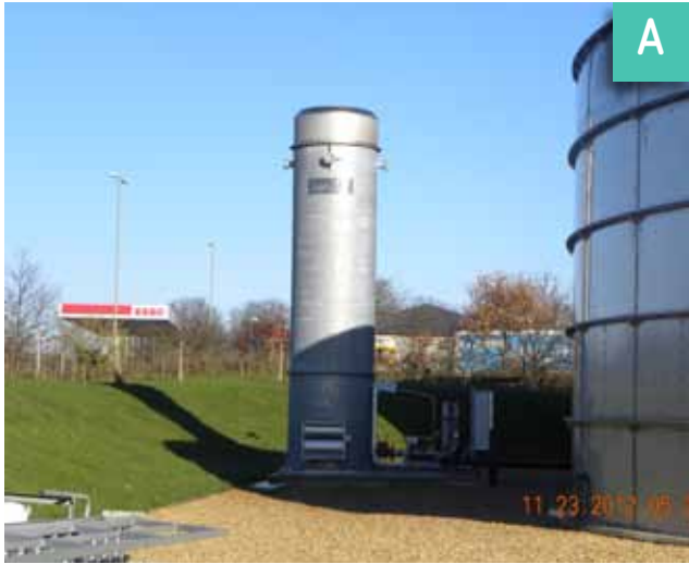
FIGURA 5.2 FOTO DE QUEMADORES: A) Y B) CERRADO; C) Y D) SEMI-CERRADO; E) Y F) ABIERTO.
