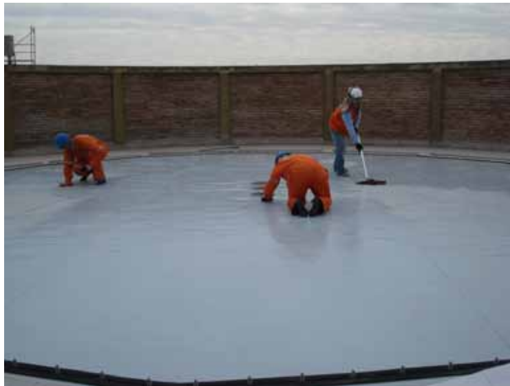
FIGURA 4.15 COLOCACIÓN DE LA MEMBRANA DE FONDO Y BOQUILLAS DE ENTRADA Y SALIDA DE BIOGÁS EN UN GASÓMETRO DE DOBLE MEMBRANA.
