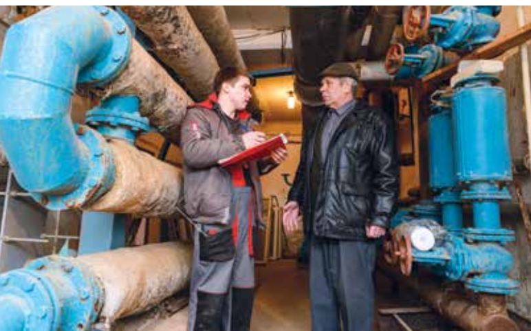
Inspektion von Heizsystemen
