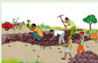
Construction d'une digue filtrante
