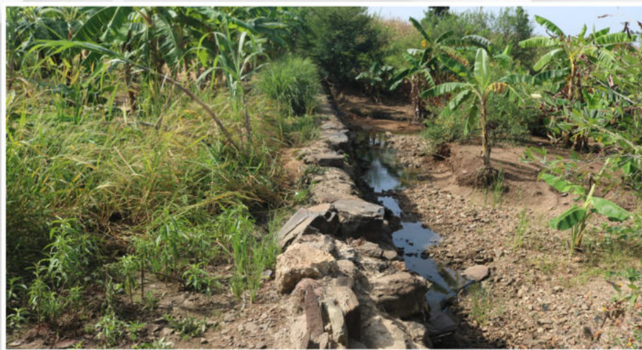
Photo 6: Barrage fait dans un bas-fond
