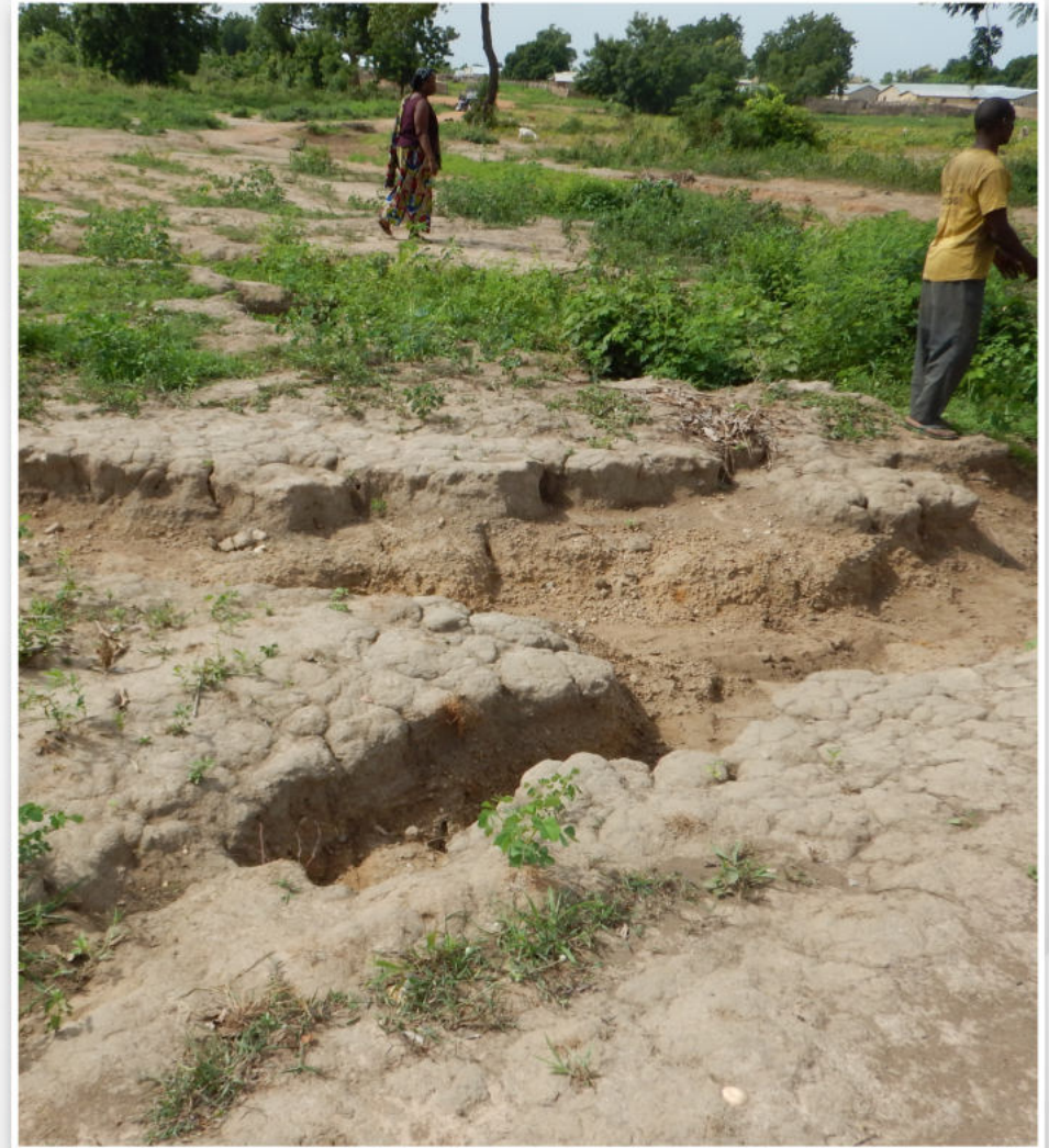
Photo 1 : Erosion à grande échelle
