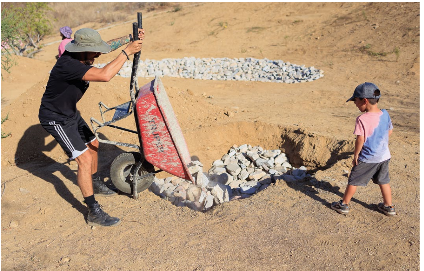
Comunidad rellenando pozo de absorción con material. ©GIZ México, Josafat de la Toba.
