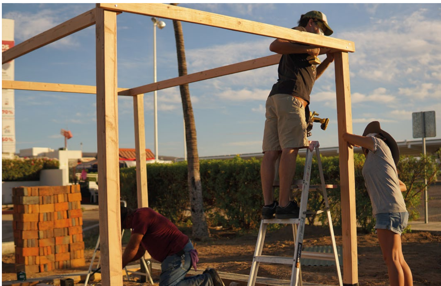
Construcción del mobiliario urbano ©Alianza Oasis Urbanos.
