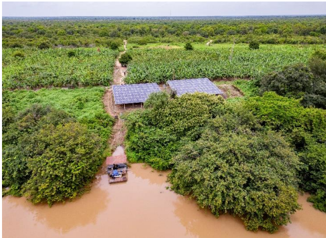
Photo : Pompe solaire pour une bananeraie © GIZ/PED Sylvain Cherkouki photographe
