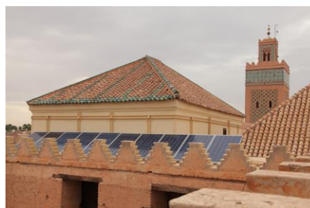
Foto links: Installation einer PV-Anlage für ein Hotel. Foto: GIZ/Adnane Azizi
