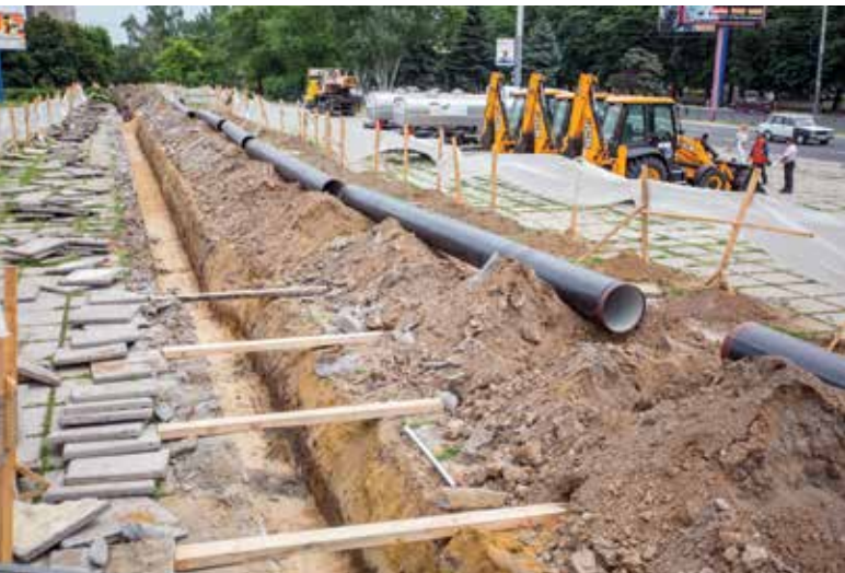
Ремонтні роботи у мережі водопостачання Маріуполя
