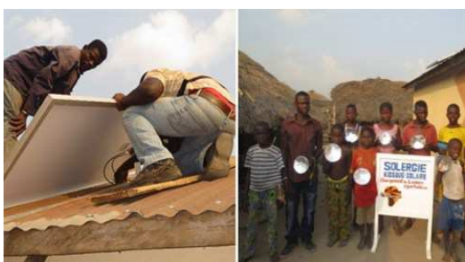
Travaux d'installation de l'entreprise Solergie
