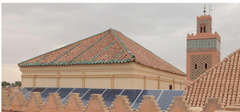
La mosquée Moulay Yazid à Marrakech a été équipée de panneaux photovoltaïques, de chauffe-eaux solaires et de lampes LED en 2016.
