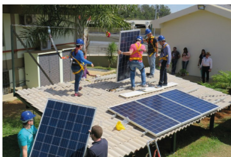
Foto 1: Montagem de módulos fotovoltaicos.
