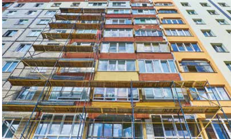
Утеплення фасаду будинку
