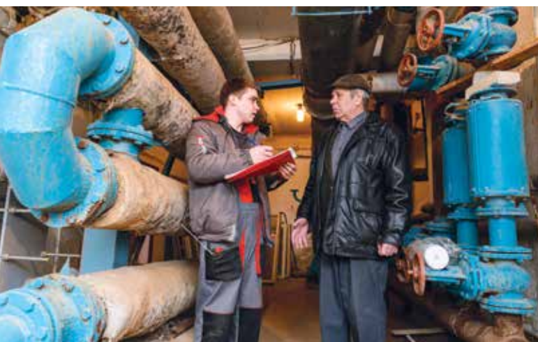
Обстеження інженерних систем
