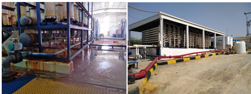
Links: Schlecht gewartete KEMAPCO-Entsalzungsanlage, die von AquaTreat für die Wasserversorgung von Aqaba betrieben wird.
