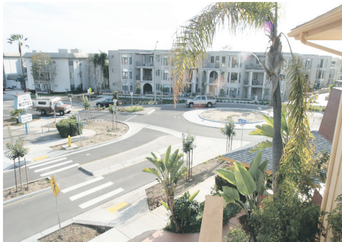
Hình 5.5. Hình ảnh minh họa giải pháp vòng đảo nhỏ tại Mỹ và Canada
