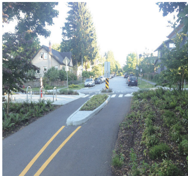
Hình 5.6. Hình ảnh minh họa giải pháp ngăn xe cơ giới tại Vancouver, Canada
