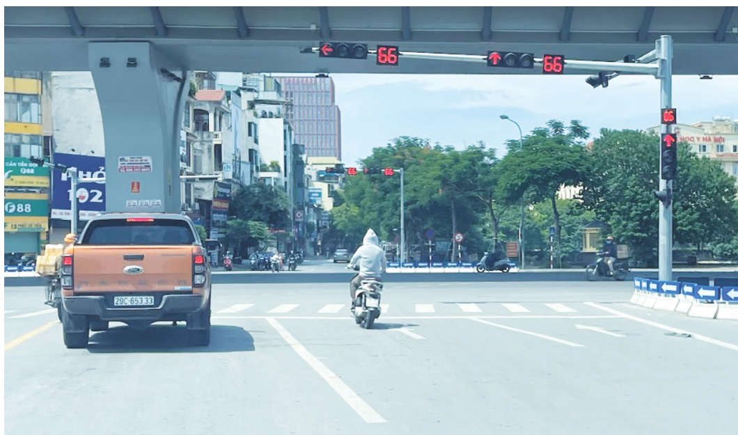
Hình 6.1. Cột cần vươn kết hợp đầu đèn gần giúp cải thiện tầm nhìn cho người đi xe đạp
