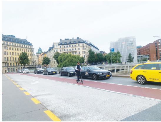
b) Làn xe đạp chỉ được bảo hộ bằng vạch sơn Người đi xe đạp ít tự tin hơn nhiều so với trường hợp tại ảnh a
