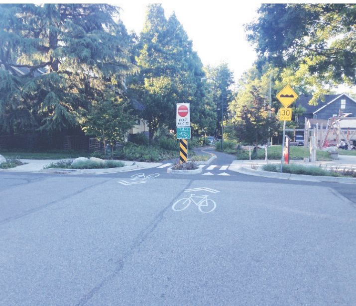
Hình 5.6. Hình ảnh minh họa giải pháp ngăn xe cơ giới tại Vancouver, Canada
