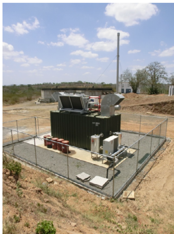
Figura 5: Unidade motor-gerador instalado na ETE Jacuípe II.
