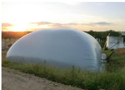
Figura 21: Gasômetro de membrana dupla na ETE Jacuípe II.
