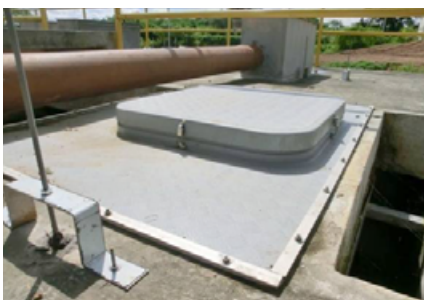
Figura 8: Calha para remoção de espuma.
