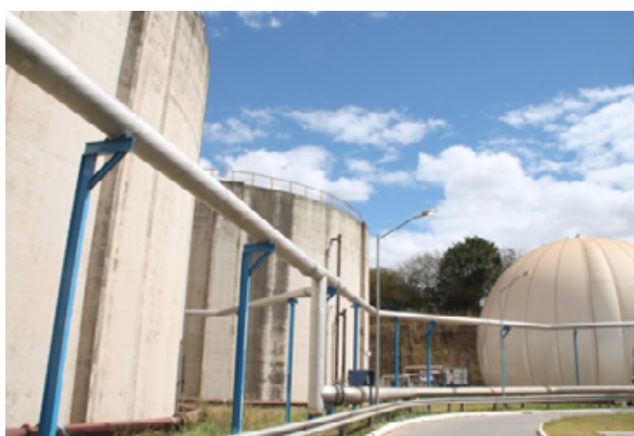
Figura 2: Biodigestores e gasômetro na ETE Arrudas.
