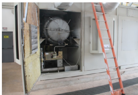
Figura 3: Microturbina instalada na ETE Arrudas.
