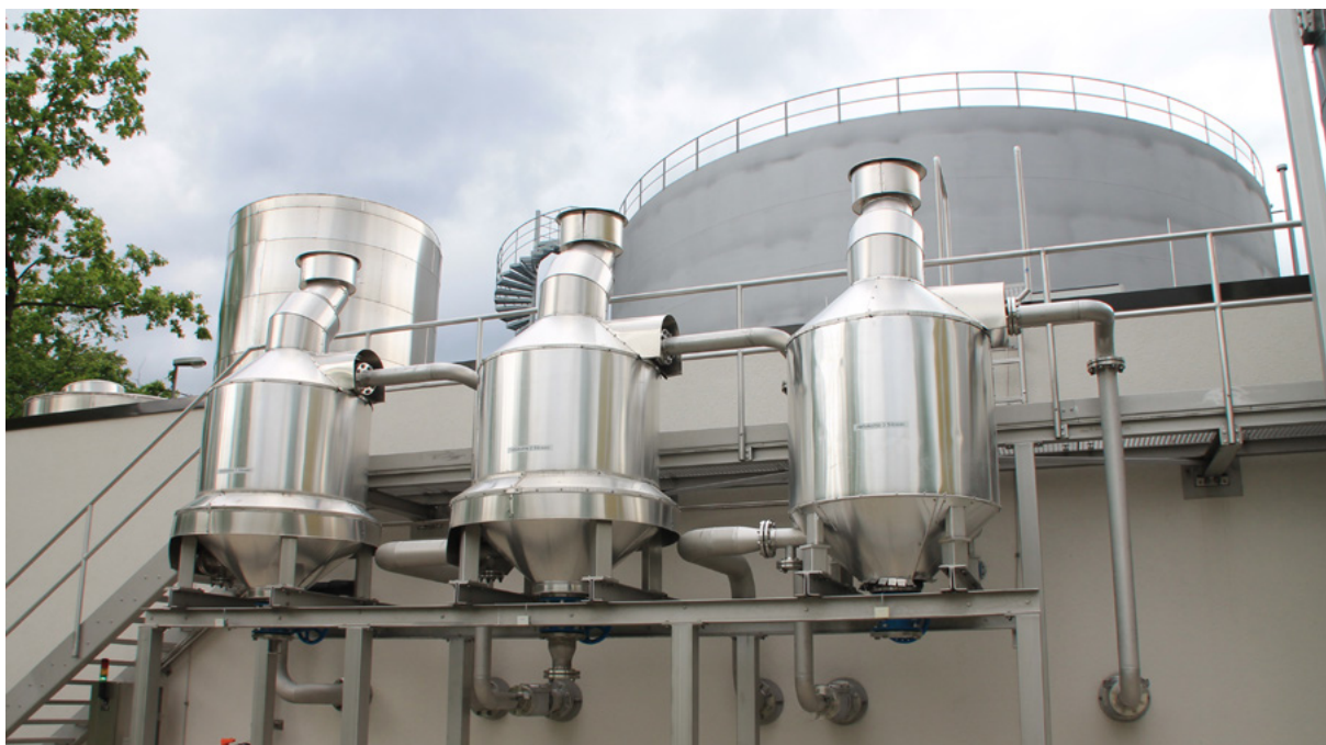
Figura 8.11: Remoção de Siloxanos por carvão ativado – ETE de Augsburg – Alemanha.
