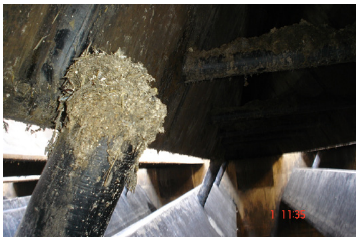
Figura 3.12: Foto da obstrução da tubulação de coleta de biogás devido à presença de espuma.
