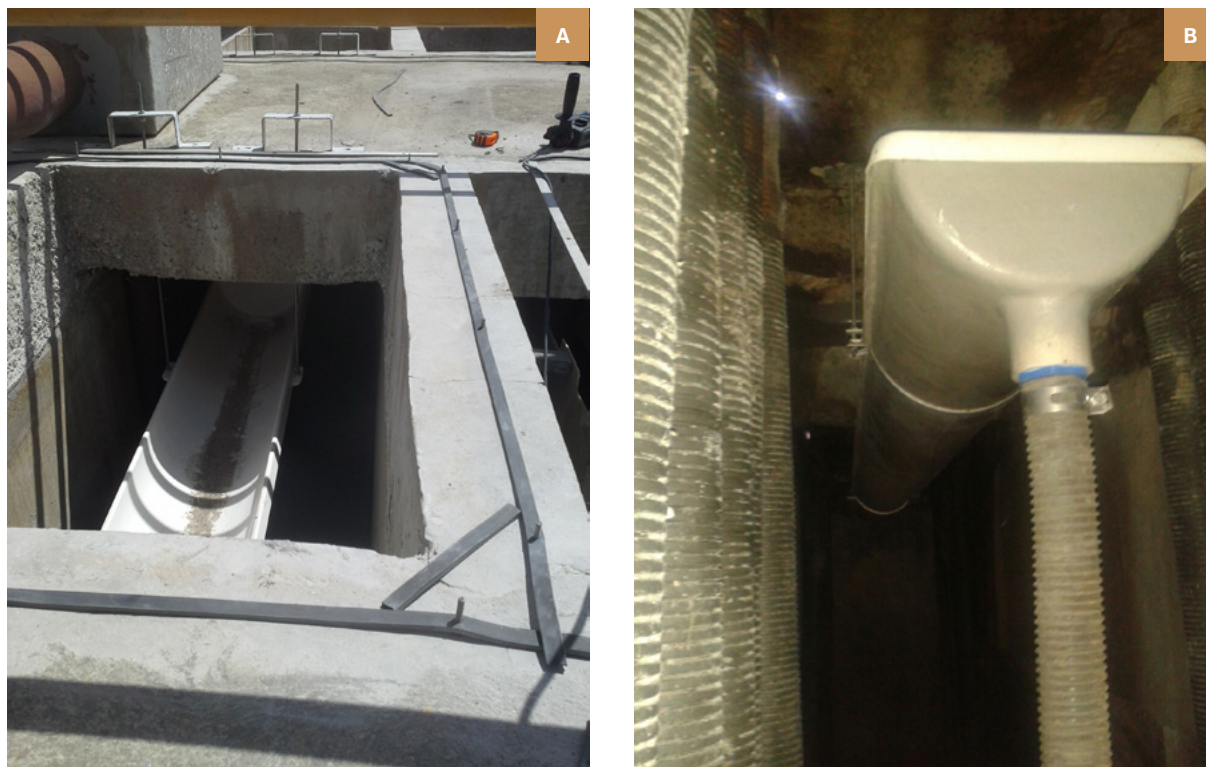
Figura 3.10: Calhas de remoção de espuma com ajuste de nível implantadas na ETE Jacuípe II: (a) vista superior; (b) vista interna do reator.
