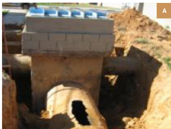
Figura 3.18: (a) Foto da canaleta de concreto sem impermeabilização, após corrosão; e (b) Foto da canaleta de concreto recuperada e impermeabilizada.
