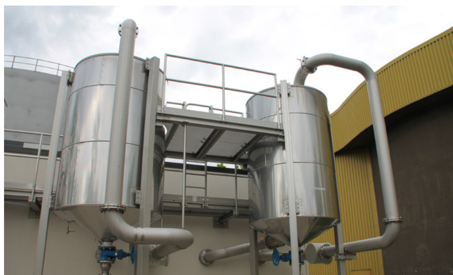
Figura 8.4: Remoção de H_2S por carvão ativado – ETE de Augsburg – Alemanha.
