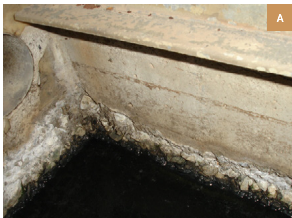
Figura 3.17: [a] Foto da canaleta de concreto sem impermeabilização, após corrosão; e [b] Foto da canaleta de concreto recuperada e impermeabilizada.
