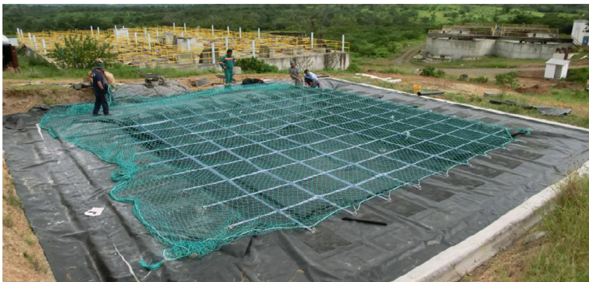
Figura 8.2: Montagem de gasômetro com biodessulfurização interna – ETE Jacuípe II – Bahia.
