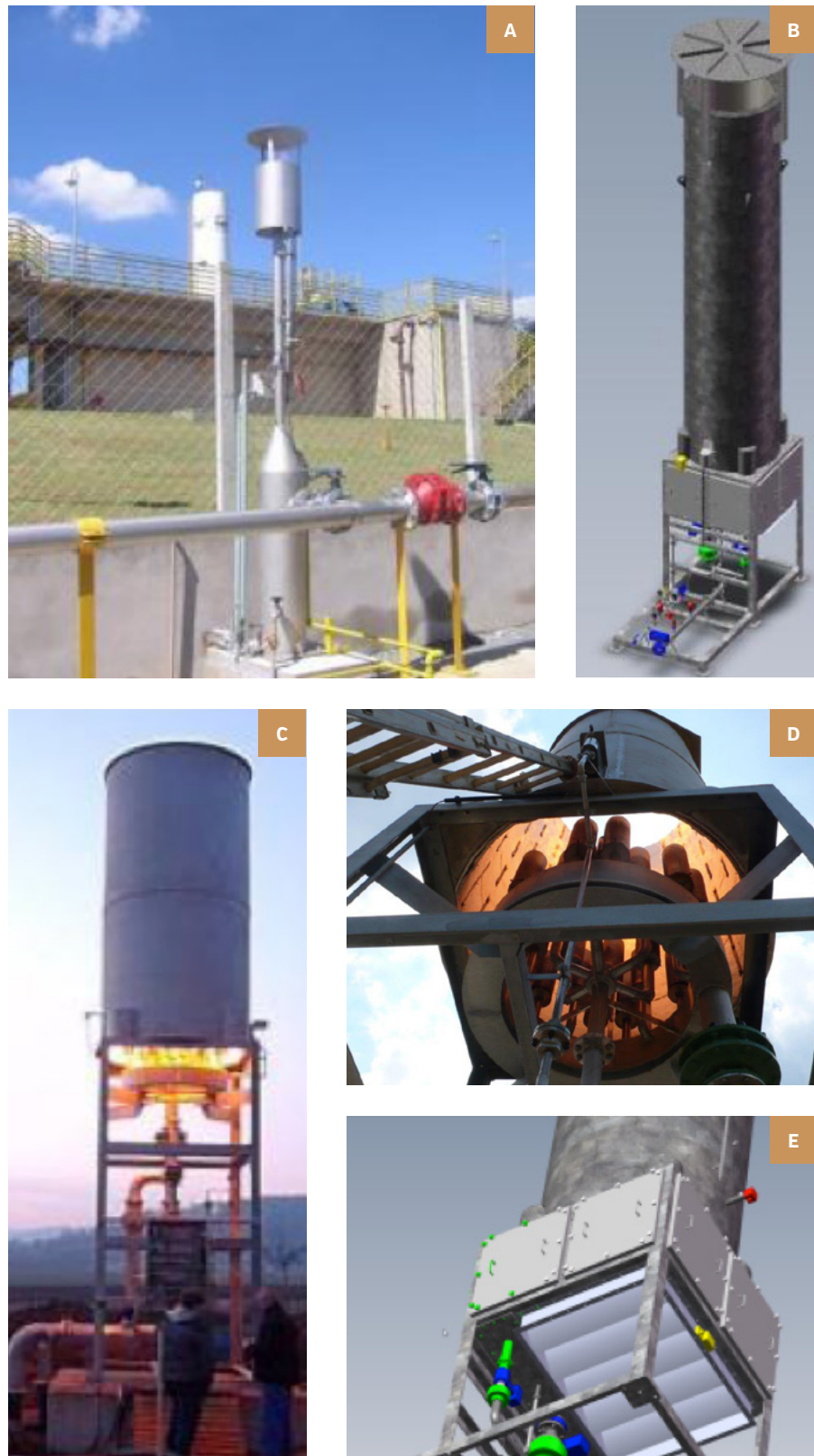
Figura 7.1: Foto de Queimadores: [a] aberto; [b] enclausurado; [c], [d] semi-enclausurado; [e] Dampers de flare enclausurado.
