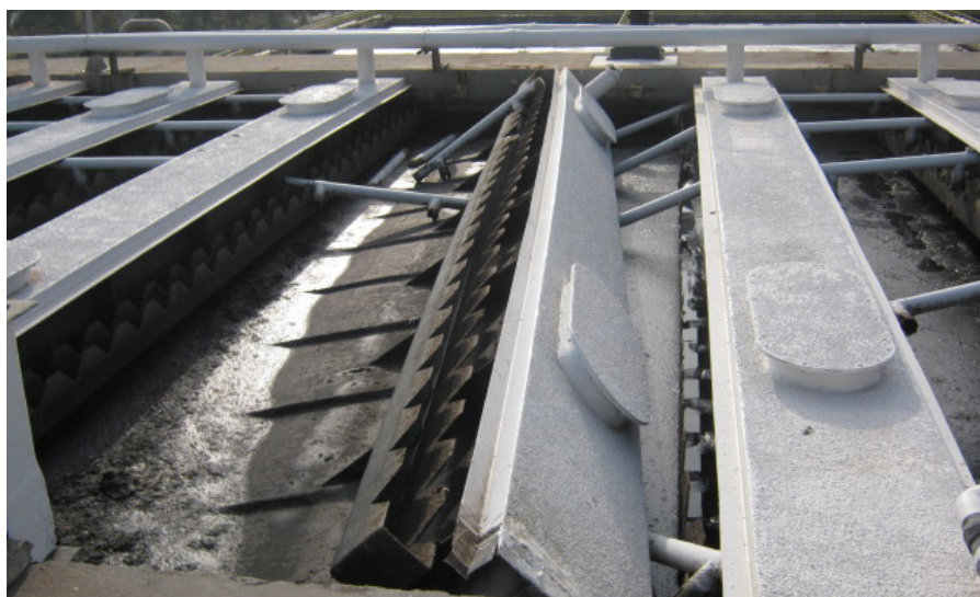
Figura 3.13: Foto do separador trifásico rompido por conta da obstrução, pela espuma, da tubulação de saída do biogás.
