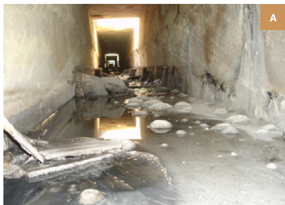
Figura 3.17: [a] Foto da canaleta de concreto sem impermeabilização, após corrosão; e [b] Foto da canaleta de concreto recuperada e impermeabilizada.
