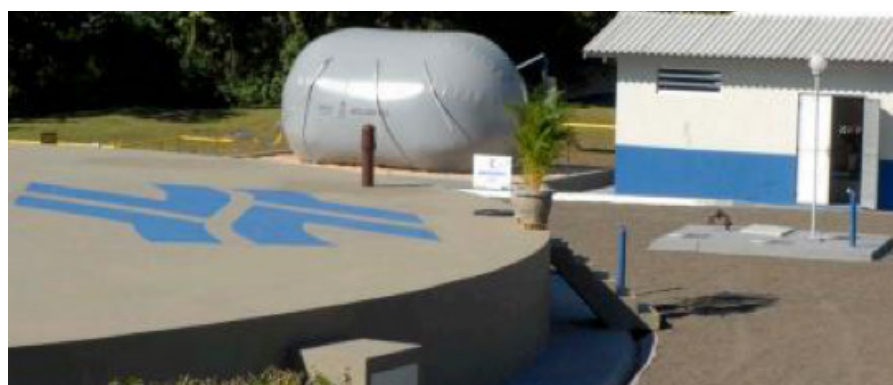
Figura 9.5: Foto do sistema de geração distribuída de energia elétrica da ETE Ouro Verde/Foz do Iguaçu movido a biogás.
