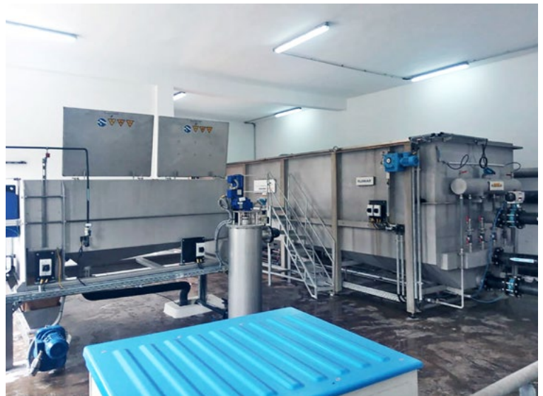
شكل ١: مُثبت بشكل موثر للمساحة - نظام تعويم Flomar® للمعالجة المسبقة لمياه الصرف والمكبس اللولبي لنزع مياه الحمأة في مصنع أسماك في المغرب
