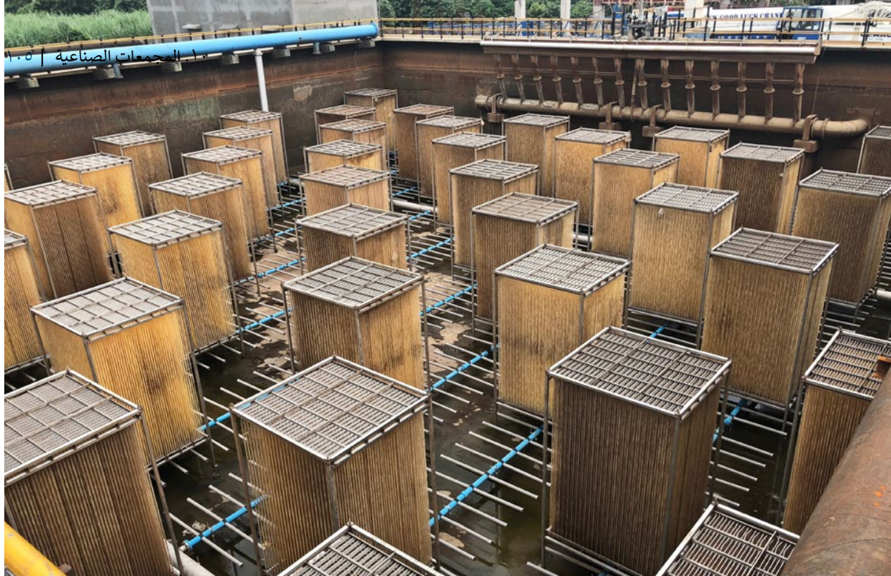
شكل ١: واحد من ستة أحواض SBR مزود بأقفاس biocurlz وأجهزة تهوية أنبوبية ذو فقاعات دقيقة
