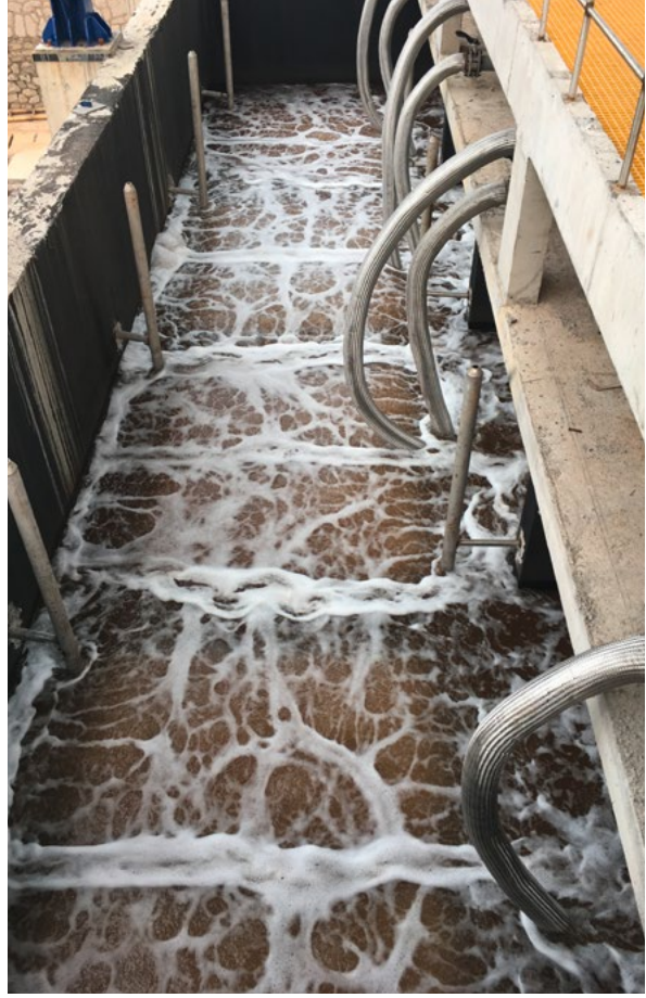
شكل ١: وحدات غشائية مغمورة (يمينا) بعد التركيب و (يساراً) أثناء التشغيل
