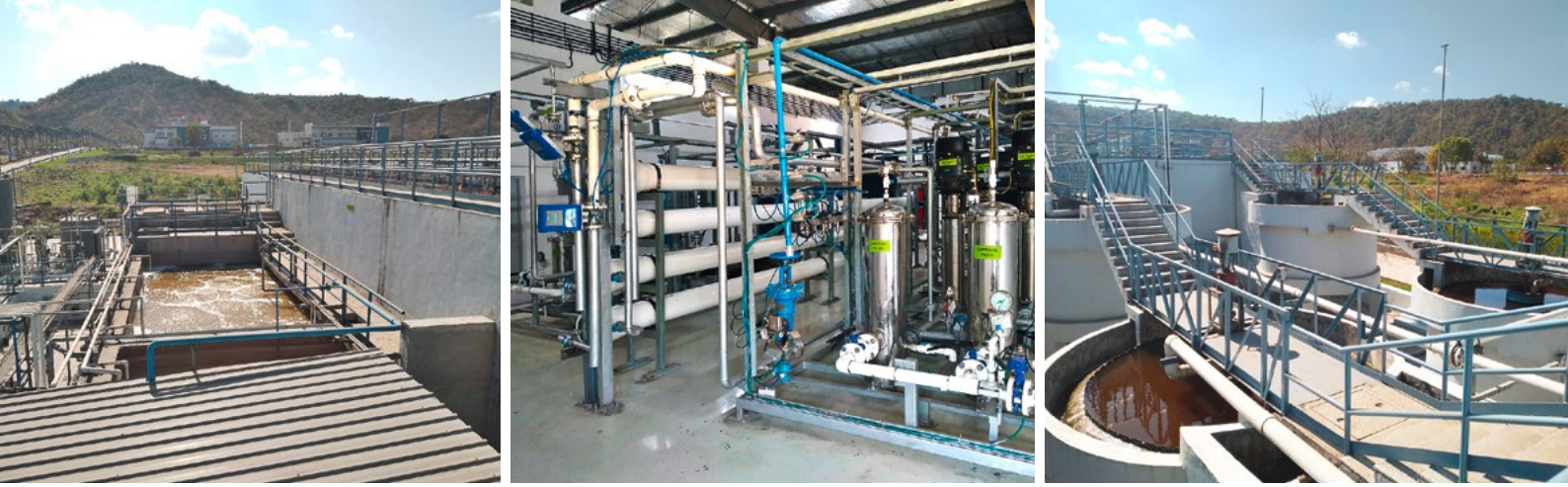
شكل ٢: سعة ٨,٣ متر مكعب/ساعة مصنع SUFRO® بالقرب من مومباي في الهند - (يسارًا) التنظيف البيولوجي (المنتصف) التناضح العكسي (يمينًا) حوض المعالجة النهائية وخزان الترشيح الفائض
