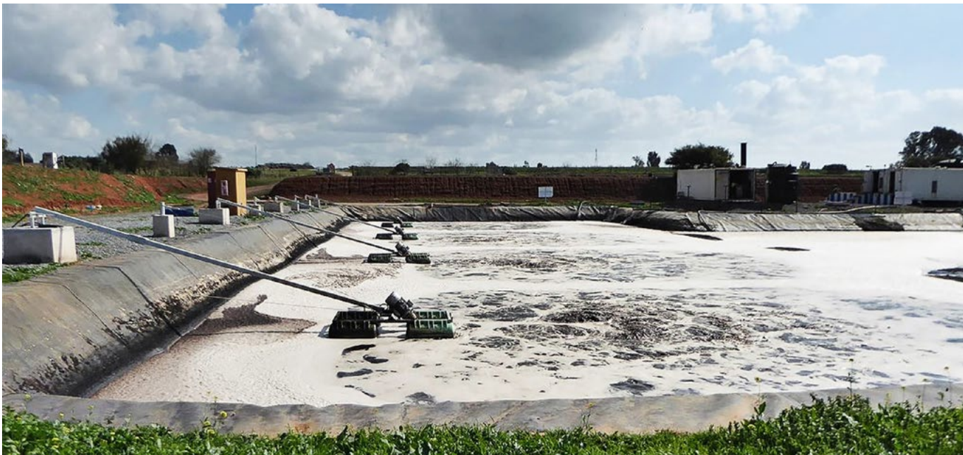
الشكل ١: التجهيز بأجهزة تهوية OxyStar في محطة معالجة مياه الرش بأم عزة في المغرب
