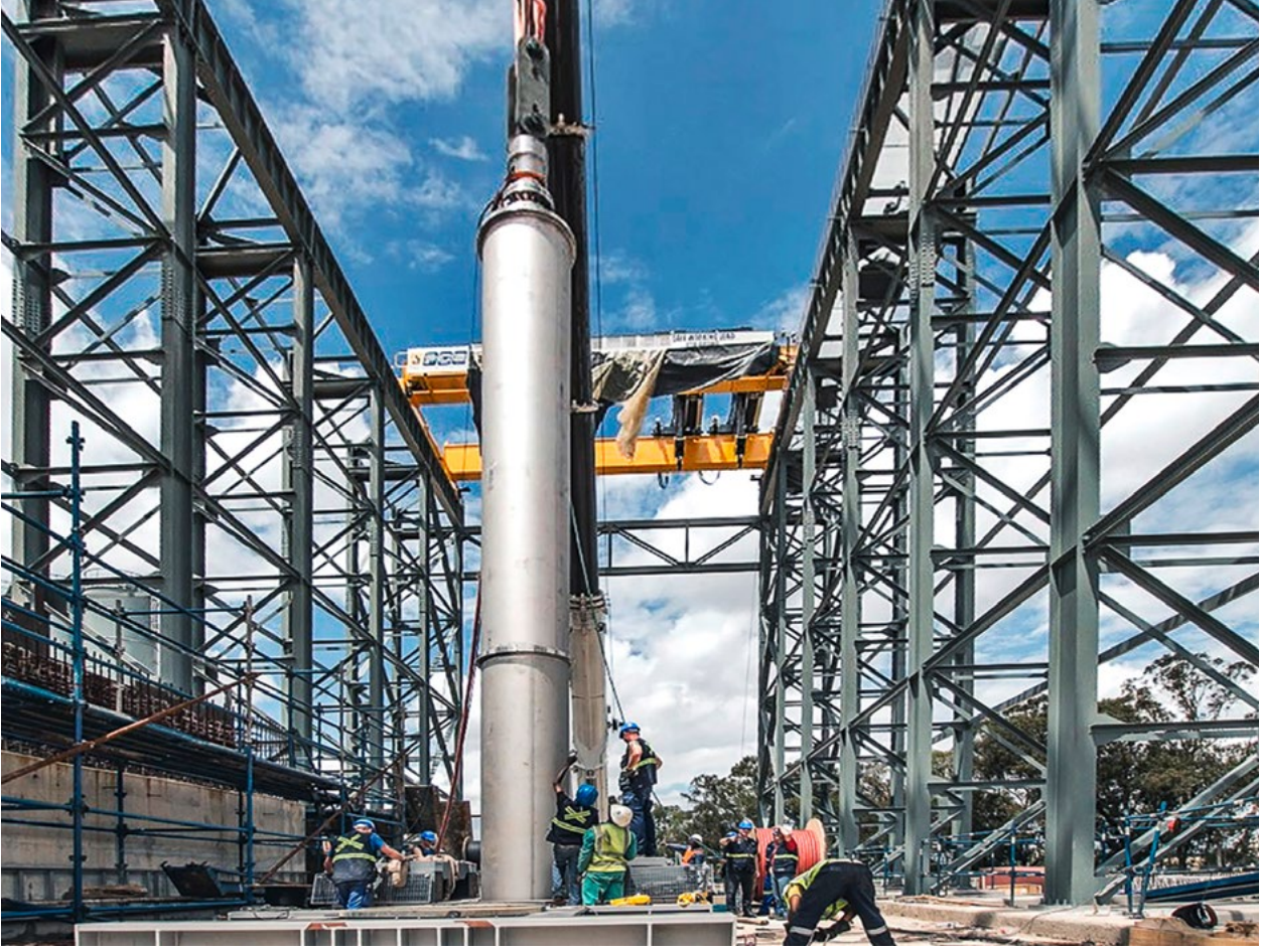
شكل ٢: تركيب إحدى مضخات ANDRITZ
