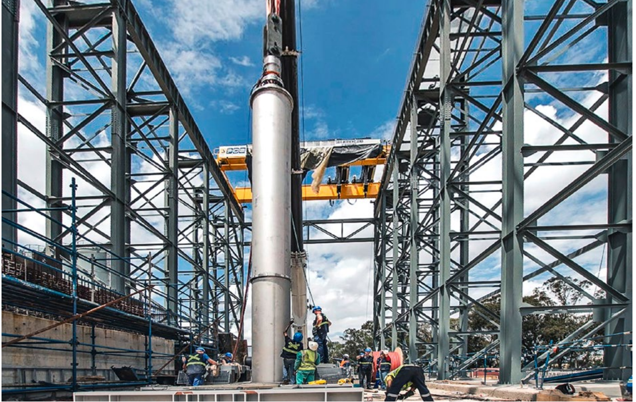
Abbildung 2: Installation einer der ANDRITZ-Pumpen
