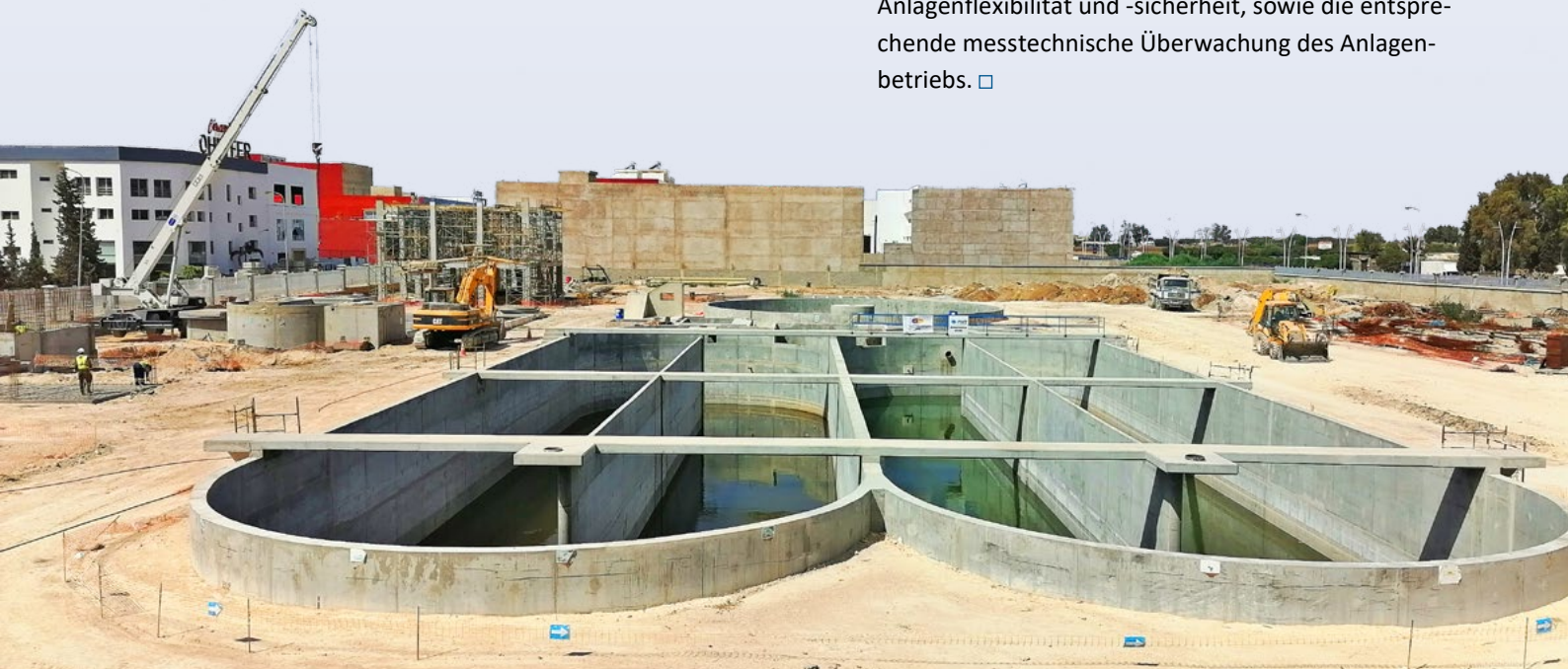
Abbildung 1: Belebungsbecken der Industriekläranlage in Nouaceur, Marokko, im Bau
