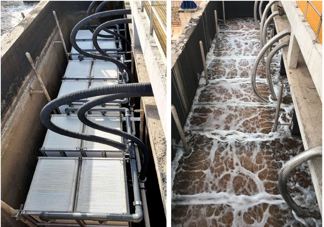
Abbildung 1: Getauchte Membranmodule nach Installation (links) und im Betrieb (rechts)
