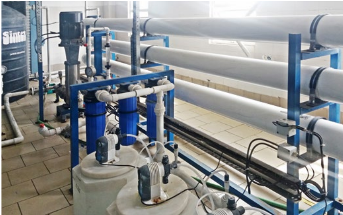
Abbildung 1: Aufbau Membranstufe mit ZLD-Technik in der Kunststoffgalvanik (links) und Bild der RO-Stufe 1 (rechts)
