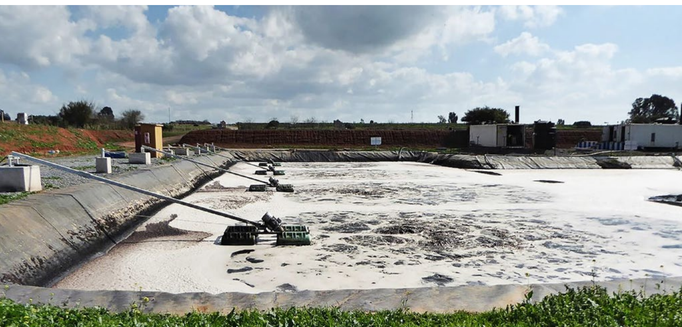
Abbildung 1: Umrüstung auf OxyStar-Belüfter in der Sickerwasserbehandlungsanlage Oum Azza, Marokko
