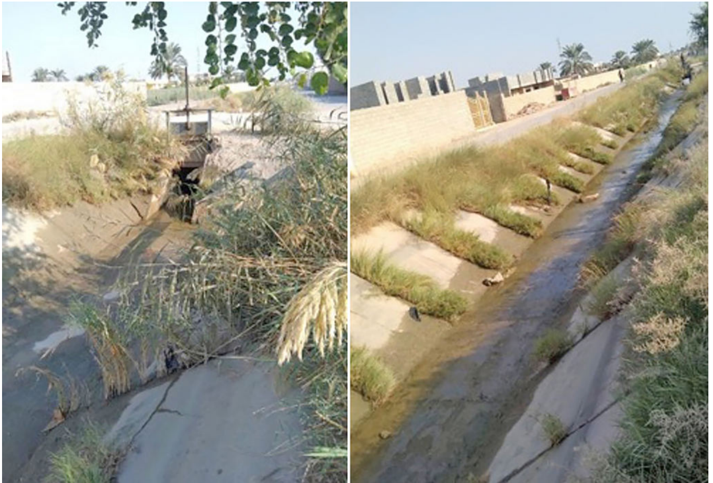
الشكل 5.7: الأضرار التي لحقت بنظام الري
